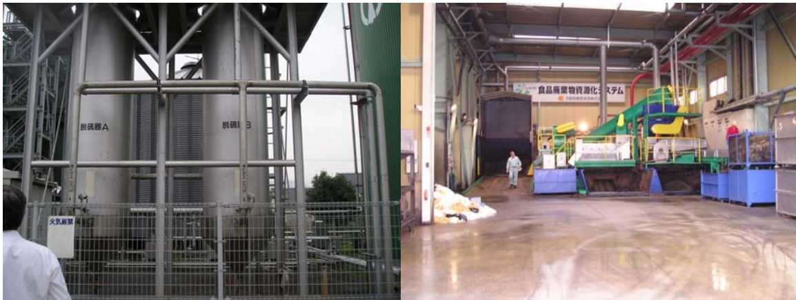
図7、バイオエコロジーセンター(南丹市)とエコの森京都(長岡京市)
